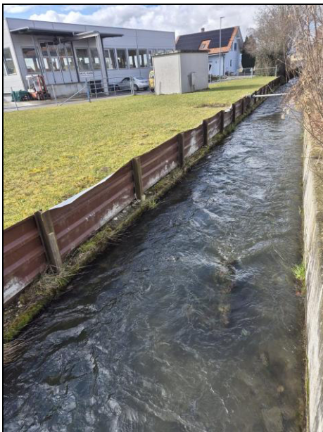
Abbildung 4: Foto von bestehender zu demontierender Blechwand
