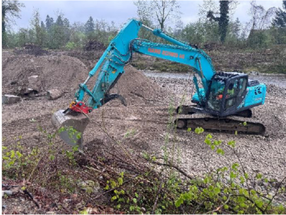
Bild 1: Abbruch bestehende Uferverbauung Seite Bätterkinden unterhalb SAB
