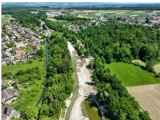
Bild 5: Sohlenaufweitung oberhalb Emmenbrücke Seite Utzenstorf
