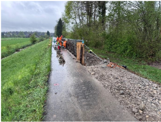
Bild 2: Erhöhung der Dammmauer entlang des Fuss- und Velowegs Seite Utzenstorf
