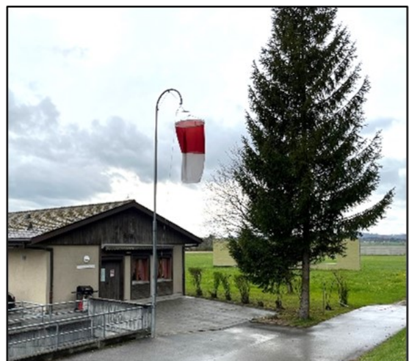
Beim Schützenhaus wird ein rot/weisser Warnsack aufgezo- gen
